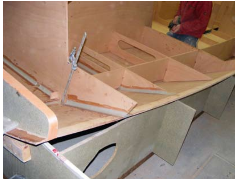
C'est parti ! Les premières pièces structurales sont stratifiées et collées à la résine époxy à la coque.
