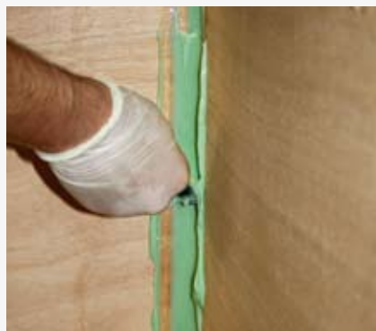
Il applique le mélange au racleur pour former un joint bien arrondi dans l'angle.
